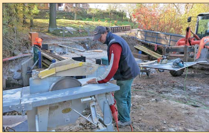
Neubau Brücke an der Mittweidaer Straße 79
