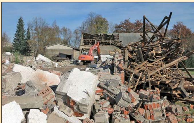
Abriss der landwirtschaftlichen Brache Berthelsdorfer Straße 8
