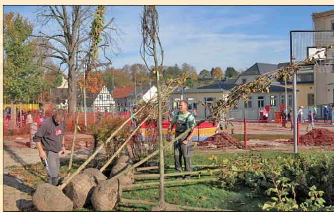
Restbepflanzungen Außenanlagen Schulzentrum
