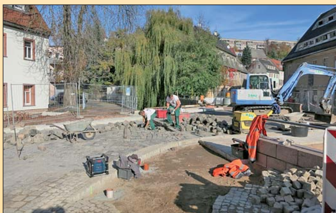
Neubau Brücke an der Ottendorfer Straße
