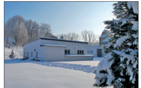
Kläranlage Hainichen im Winter
