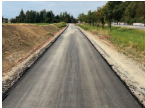
Radweg an der B169 zwischen Gersdorf und Falkenau, Baubeginn am 03.06.2024
