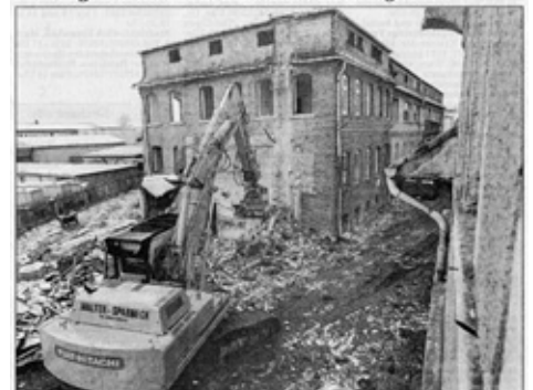
Ehemalige Möbelfabrik in Hainichen werden abgerissen
